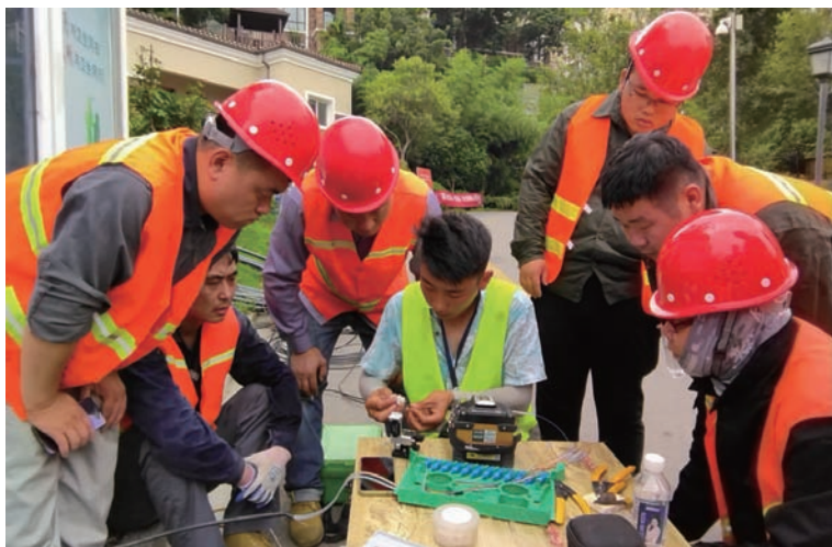
近期，台北翔立分公司经过与中移建设有限公司多次沟通，就长期承揽通信线路工程签订合作协议，这是台北投资公司新项目开发又一成果。图为翔立分公司职工前往作业现场向移动公司工作人员学习光交箱熔纤技术。（婧娴 袁桂诚）
