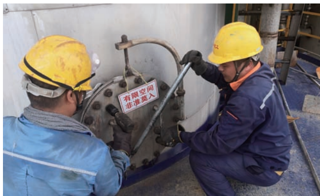
7月20日，利海化工公司为期15天的双氧水装置大修工作顺利结束。此次大修完成了离心空压机、氢压机、真空泵、循环水阀门等17项检修任务，将大大提升双氧水装置氯化塔反应效果和产品质量。图为员工对双氧水装置白土床安装入孔。（徐洁 林涛）
